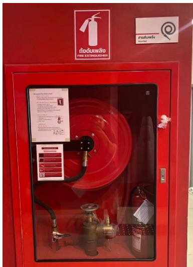
ภาพที่ 9 แสดงถังดับเพลิงและอุปกรณ์ดับเพลิง
